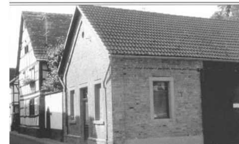
Das „Untere Backhaus“ Ecke Bachgasse / Backhausgasse
