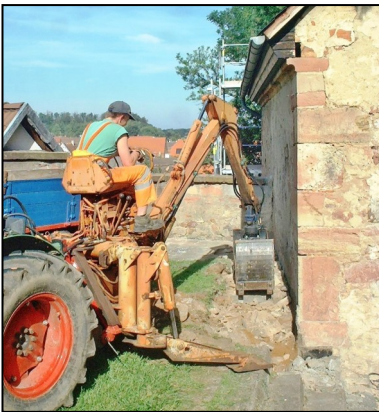
Freilegung der Außenmauern
