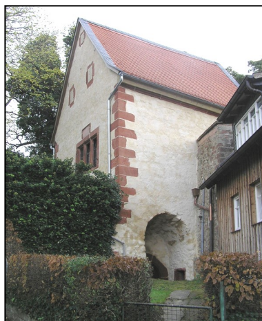
Der Kellereingang von der Treppe am Ende der Mühlgasse aus
