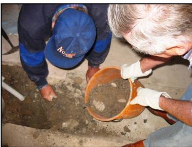
Vorsichtiges Ausheben des Stichgrabens
